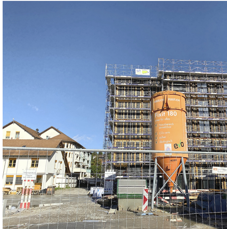
Blick auf die Baustelle des Neubaus neben dem bisherigen Alterszentrum.
