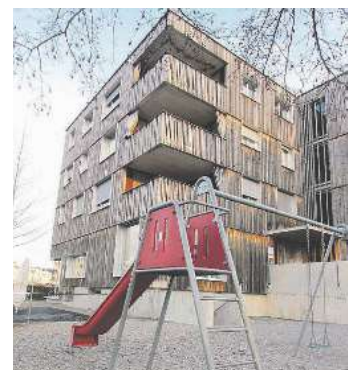
Familienzentrum Gries. BILD RENÉ BRECHBÜHL
